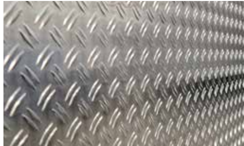
Bodenplatte mit Aluriffelblech belegt
